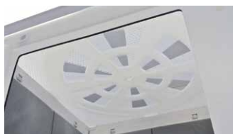
天井には採光性のある素材を使用
